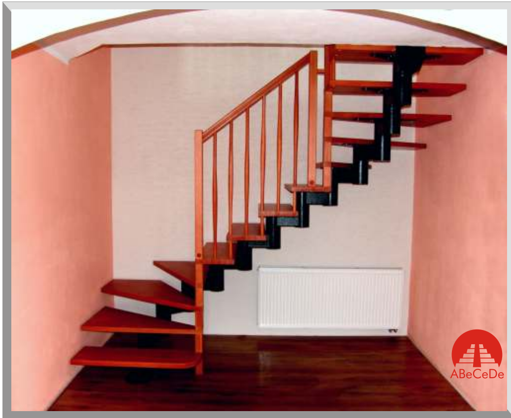
BOČNÍ KOTVA KOTVENO DO STĚNY
